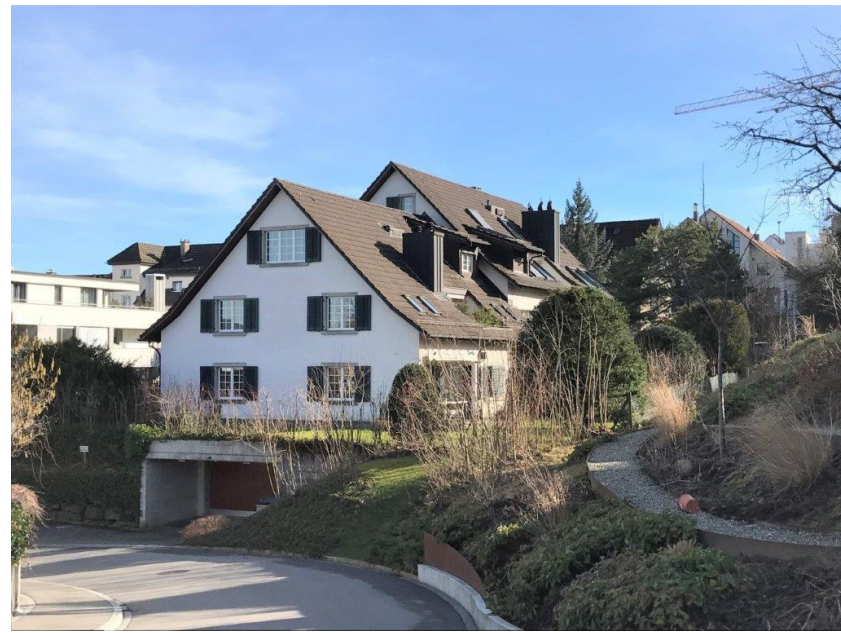
Ansicht von der Rohrstrasse mit Garageneinfahrt / Besucher-PP
