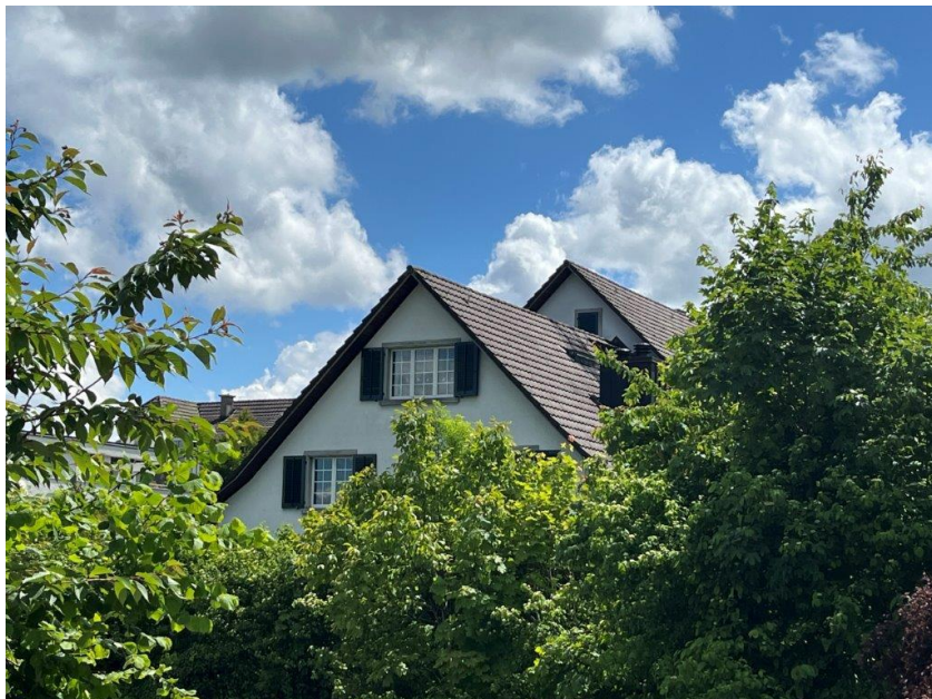
Blick von Nordwesten aufs Ober- und Dachgeschoss
